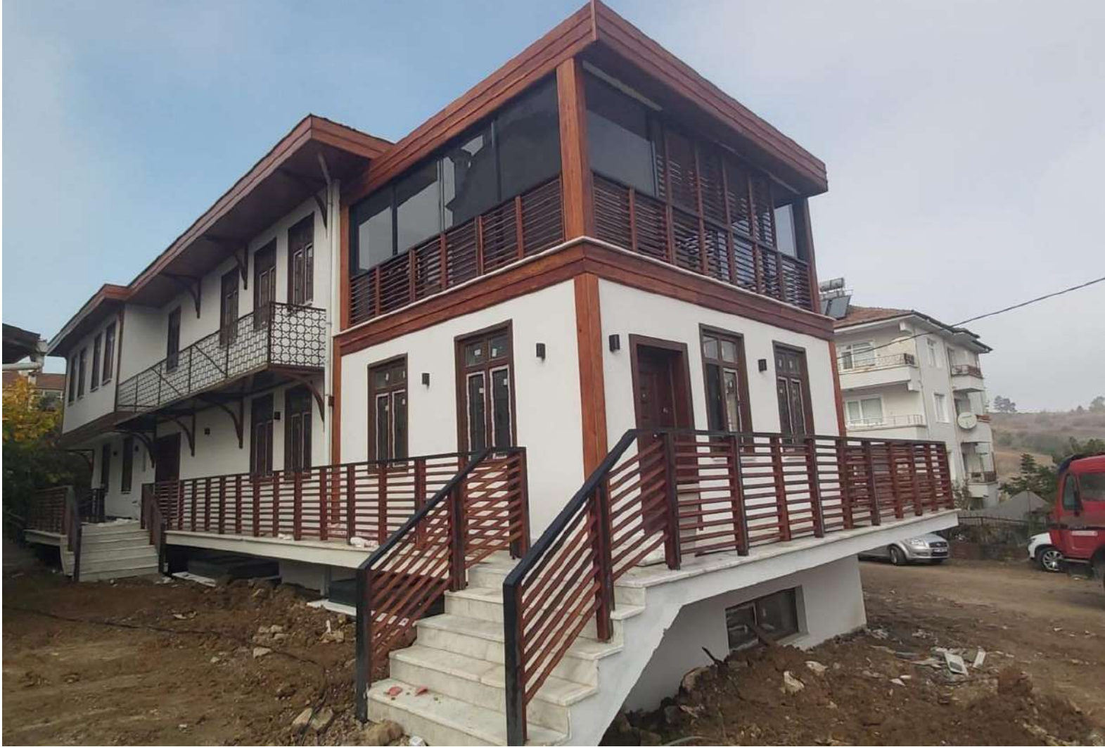
Yenimahalle Köy Binası
